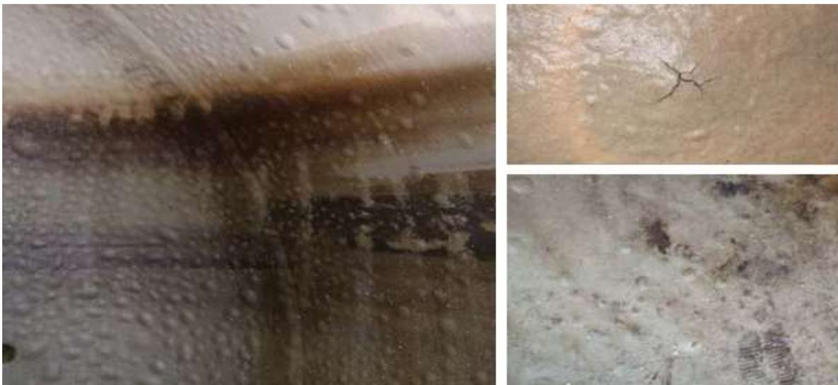
**Figura 10.4.4 – Empolamento e degradação do revestimento interno (como na IVI mais recente)**
